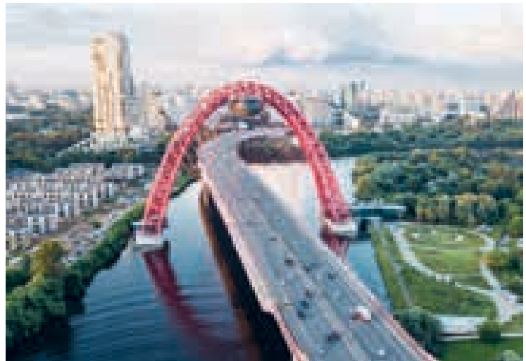
Zhivopisny 景觀大橋是莫斯科河上第一座斜拉橋
