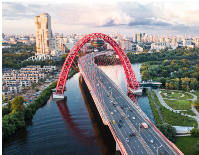
Живописный мост – первый вантовый мост через Москву-реку
